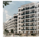
Berlin 2021- Segelfliegerdamm Neubau eines Wohngebäudekomplexes, im der Bauwert AG
